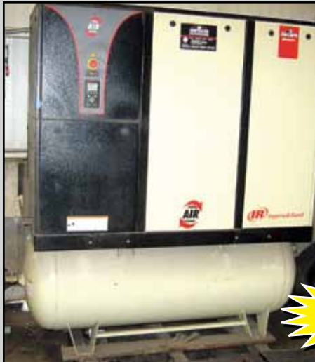
INGERSOLL-RAND AIR COMPRESSOR
